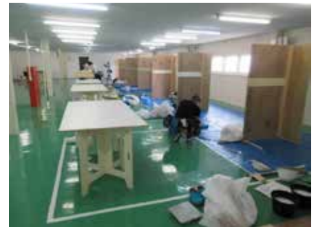
随時3級 壁装作業
